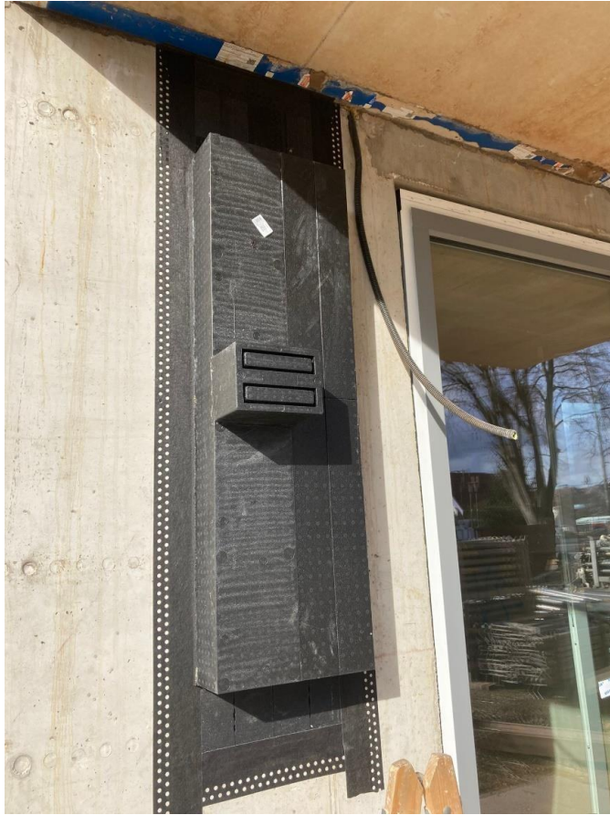
Dichtband Siga Fentrim 2 (schwarz) an Baugruppe Lüftungsgerät und Verteiler anbringen und mit Wand verkleben
